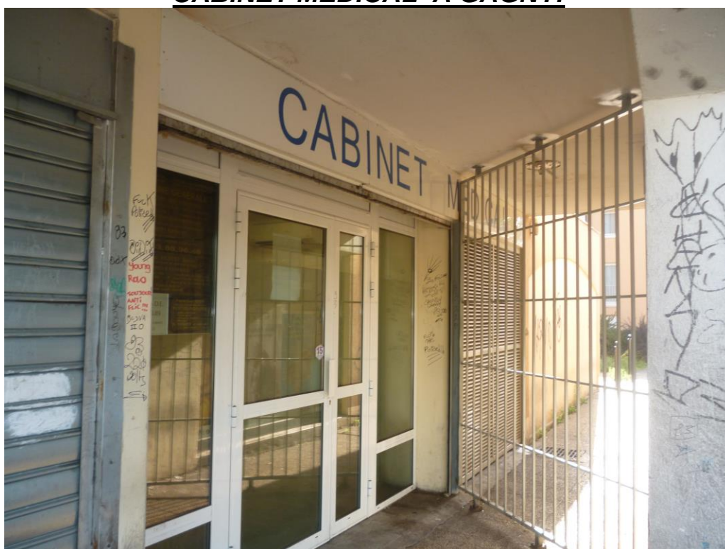
Entrée du cabinet médical. Au second plan, installation d'une unité de climatisation réversible air/air. Octobre 2011. Erp. DET,AOR,DOE.
