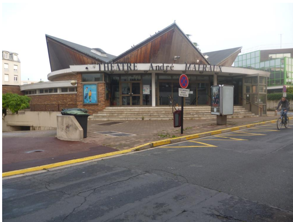
Architecture circulaire avec parements flammés.
