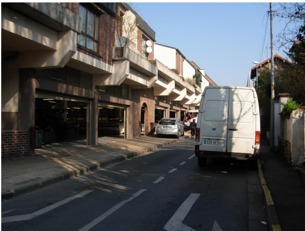
Le marché du centre.RDC. Restructuration générale. Mai 2008. Erp. PC,DCE,DET,AOR,DOE.
