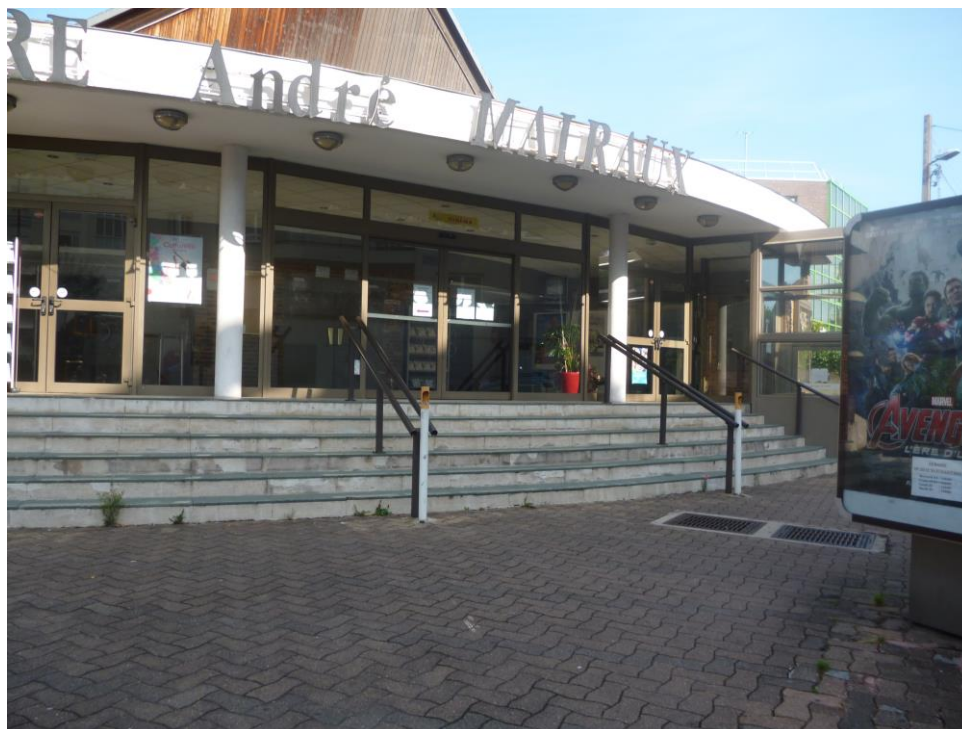
Aperçu du hall d'accueil.
