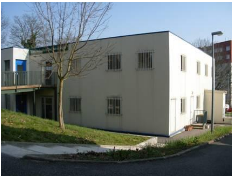
Restructuration du centre multi-accueil de Gagny. Janvier 2007. Erp. PC,DCE,DET,AOR,DOE.
